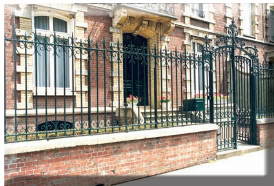
Hôpital de jour de Beauvais
